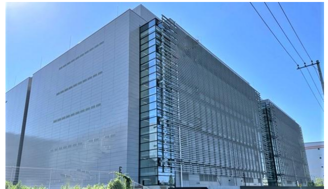
図表4 エクイニクスのデータセンター
